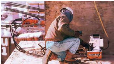
PE60-Pumpe im Einsatz bei Spannarbeiten.
