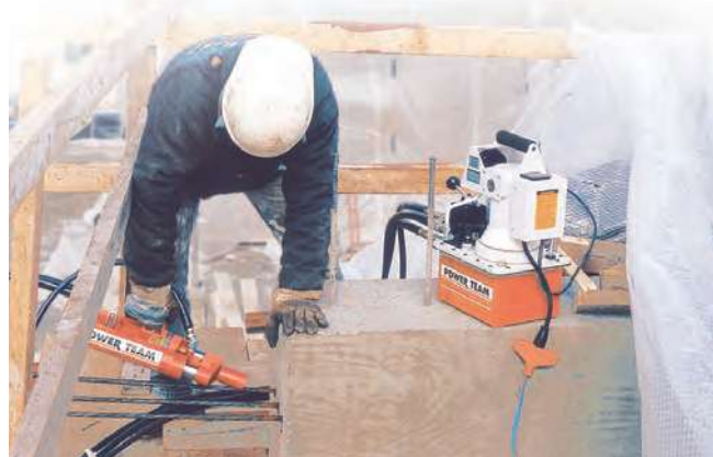
PE60-Pumpe im Einsatz bei Spannarbeiten.
