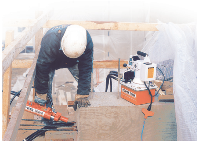
PE60-Pumpe im Einsatz bei Spannarbeiten.
