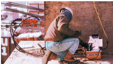
PE60-Pumpe im Einsatz bei Spannarbeiten.
